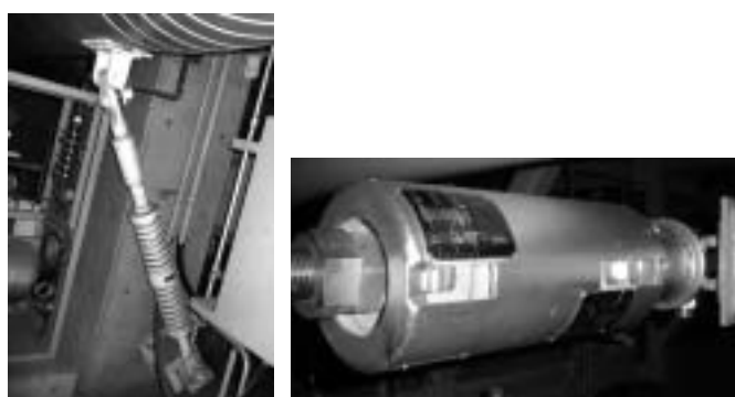
図1 ばね式防振器(左が揺動防止タイプ、右が振動防止タイプ)
